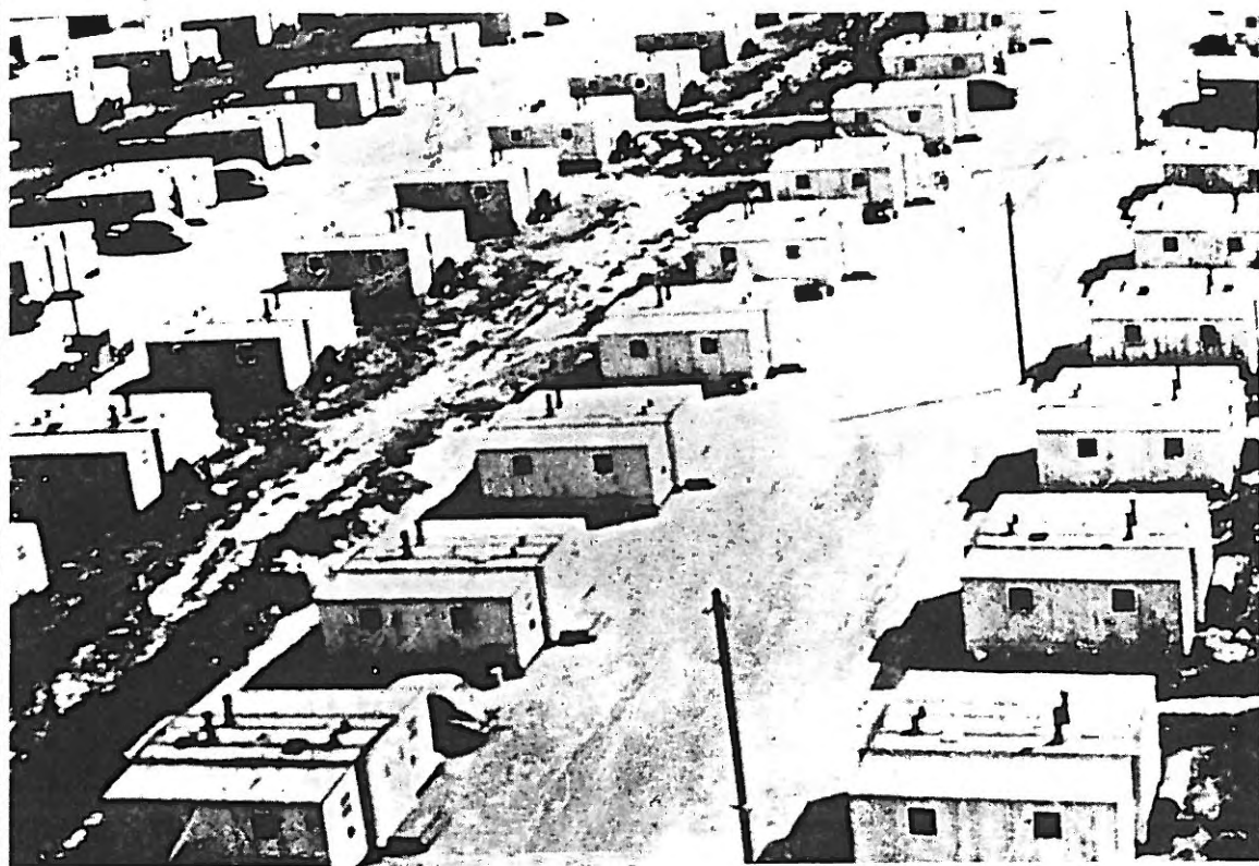
Willow Court - 5 000 jednotek vojenského ubytování pro leteckou továrnu. Dřevotřískové prefabrikované domy dovezeny z výroby kompletní na místo /1944/
