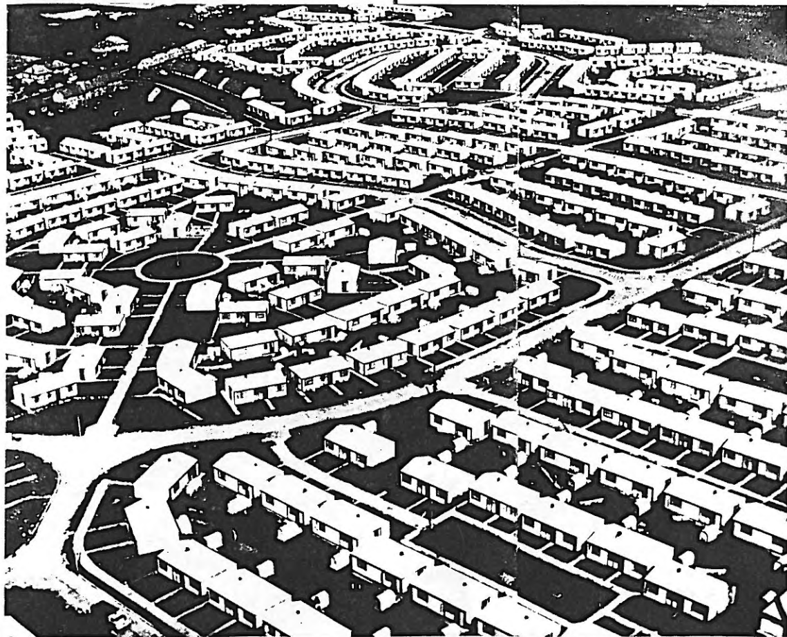
Arcon - asbestocementové prefabrikované domy, vyrobené za války ve 40 000 serií v továrně na munici. Jejich cena začala ke konci války stoupat. Proto byla poválečná objednávka snížena ze 1/4 milionu na 150 000
